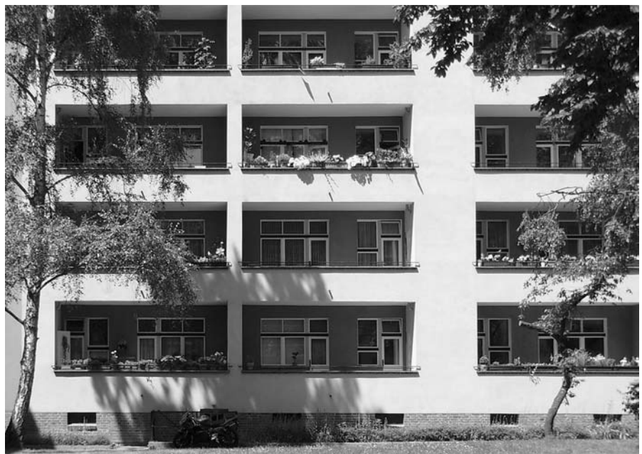
Städtischer Wohnungsbau der 20er Jahre hier am Beispiel der Wohnstadt „Carl Legien“ in Prenzlauer Berg. Durch „Licht, Luft und Sonne“ wurde die Wohnqualität gegenüber den Mietskasernen deutlich verbessert.
