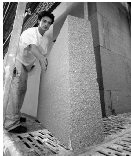
Die Kosten für das Baugerüst gehören in der Regel zu den umlagefähigen Modernisierungskosten, z. B. wenn die Fassade mit Wärmedämmung versehen wird.
