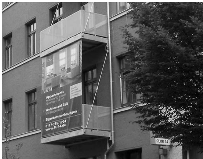
Modernisierung und Umwandlung im Milieuschutzgebiet Bergmannstraße-Nord.
