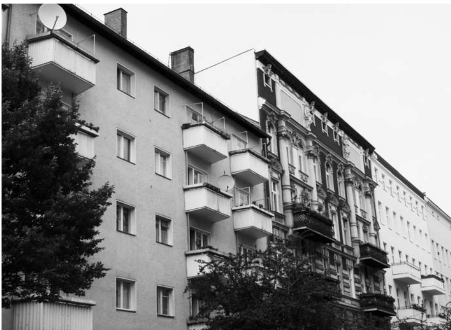
Immer teurer werden vor allem die früher besonders günstigen Wohnungen. Die Mieten der unsanierten Gründerzeitaltbauten und der 50er-Jahre-Gebäude sind laut Mietspiegel überdurchschnittlich gestiegen.
