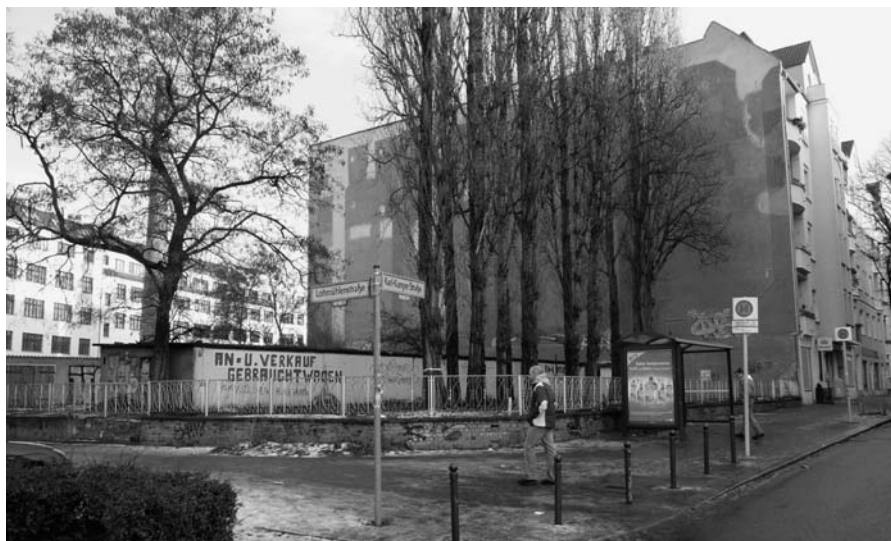
Auf diesem Grundstück an der Ecke Karl-Kunger-Straße und Lohmühlenstraße in Treptow will eine Baugruppe das Projekt „KarLoH“ verwirklichen. Für den Neubau ist das Fällen der Pappeln geplant.
