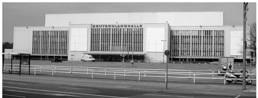
Oben: Die unter Denkmalschutz stehende Deutschlandhalle, die zur Messe Berlin gehört. Die über ca. 10.000 Sitzplätze verfügende Halle wurde 1935 fertiggestellt und nach Kriegsschäden wiederaufgebaut. Die letzte Sanierung erfolgte erst 1997 bis 2001. Der Abriss der Deutschlandhalle wurde im Mai 2008 vom Senat beschlossen.
