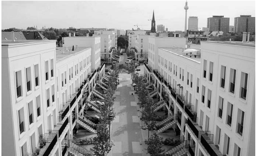
Mit den sog. Prenzlauer Gärten im Bötzw-Viertel ist auf einer ca. 15.500 qm großen Fläche ein Townhouse-Quartier entstanden. Neben 60 Townhouses wurden zahlreiche weitere Wohnungen mit gehobenem Standard, z. T. Penthouses mit Blick auf den Volkspark Friedrichshain, errichtet. „Im Bötzw-Viertel in Berlin-Prenzlauer Berg lebt ein interessanter Mix aus Anwälten, höheren Angestellten, Politikern und Kreativen“, so das Marketing der Investoren.
