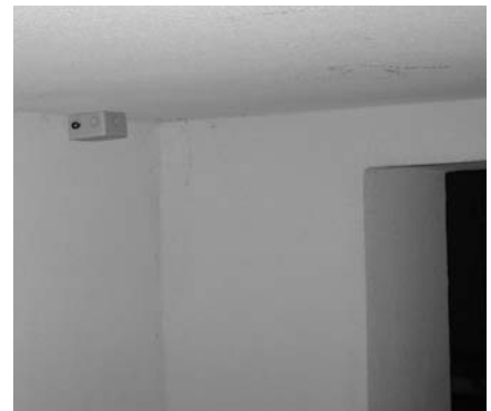
Videokamera zur Überwachung der Mieter/innen in der Bödikerstraße 9/10.
