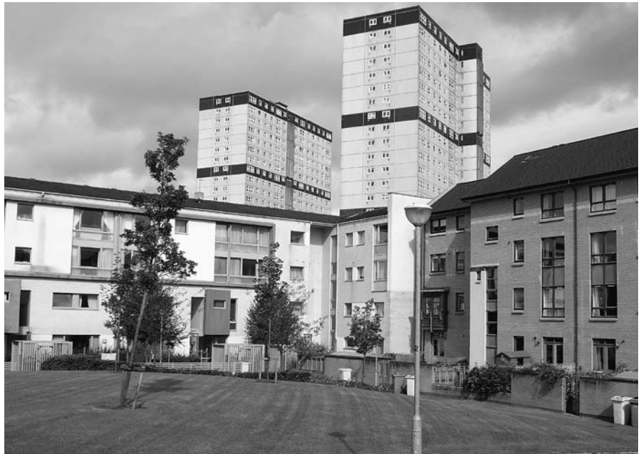
Die Glasgower Gorbals heute: Begrünter Innenhof, umgeben von neuen Eigentums- und Mietwohnungen. Im Hintergrund die alten Punkthochhäuser des sozialen Wohnungsbaus.
