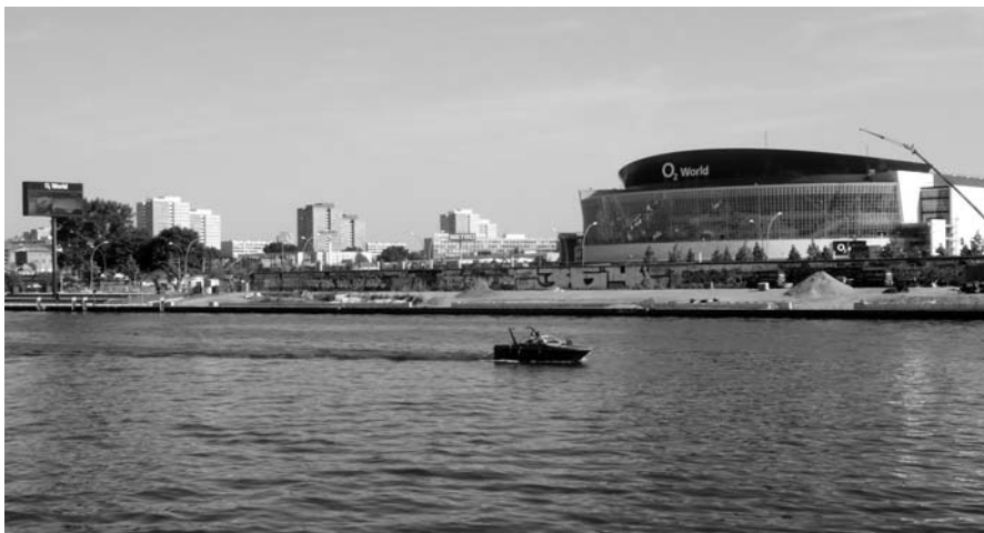
Die O 2 -World ist eine multifunktionale Veranstaltungshalle an der Spree zwischen Ostbahnhof und Warschauer Straße im Bezirk Friedrichshain-Kreuzberg. Die Halle ist Teil der Mediaspree-Planungen und steht nach knapp zwei Jahren Bauzeit nun kurz vor der Fertigstellung. In der Halle, die bis zu 17.000 Sitz- und Stehplätze verfügen wird, sollen Sportveranstaltungen wie Eishockey und Basketball sowie Konzerte stattfinden. Nach eigenen Angaben bietet die O 2 -World fünf Mal mehr Platz als das Bundeskanzleramt. Es wird die größte Veranstaltungshalle Berlins werden. Bauherr ist die Anschutz Entertainment Group, die weltweit Stadien, Hallen und Theater betreibt. Das Unternehmen O 2 Germany erwarb die Namensrechte an der Veranstaltungshalle.
