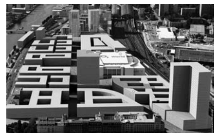
Teil der Mediaspree-Planungen: Das Anschutz-Areal mit der neuen O 2 -Arena als Luftbildmontage.
