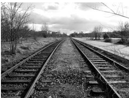
Weite Flächen und unbenutzte Gleisanlagen.
