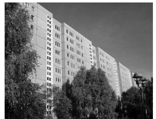
Hochhäuser neben den Ringkolonnaden in Marzahn.
