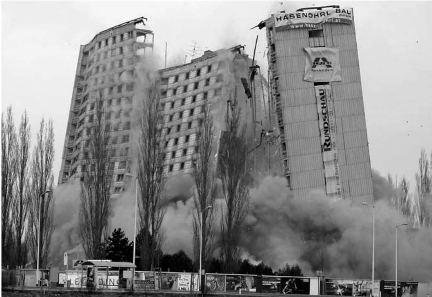
Teil des Programms „Stadtumbau Ost“: Abriss von rund 4300 Wohnungen in Berlin.
