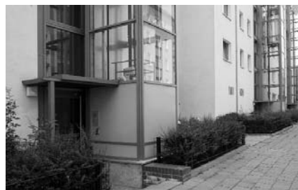
Bei Vollwahrungsverträgen von Aufzügen gehören die Instandhaltungsarbeiten nicht zu den Betriebskosten.
