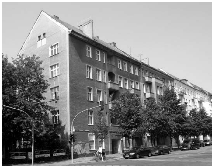
Über ein Fünftel aller angemessenen Wohnungen befinden sich in unsanierten Gebäuden. In diesen Wohnungen gibt es entweder keine Zentralheizung oder kein Bad oder beides fehlt.
