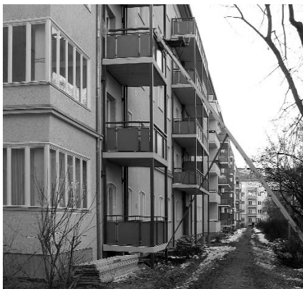
Siedlung am Grazer Damm während der Modernisierung.
