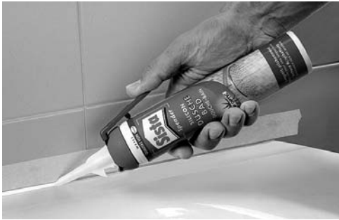
Im Fachhandel gibt es mittlerweile auch Einwegkartuschen mit Silikon, sodass der Kauf einer Silikonspritze entfällt.
