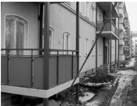
Modernisierung am Grazer Damm: Balkonanbau im Februar.
