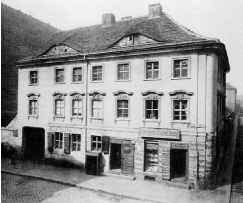
Barockes Berliner Wohnhaus, bei dem sich die Beletage (frz. bel étage = das schöne Geschoss), außen abzeichnet. Fotografie von F. Albert Schwarz aus dem Jahr 1888.
