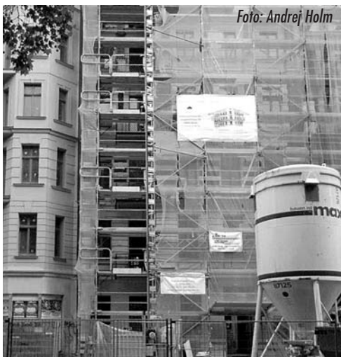
Sanierung in der Kollwitzstraße in Prenzlauer Berg.
