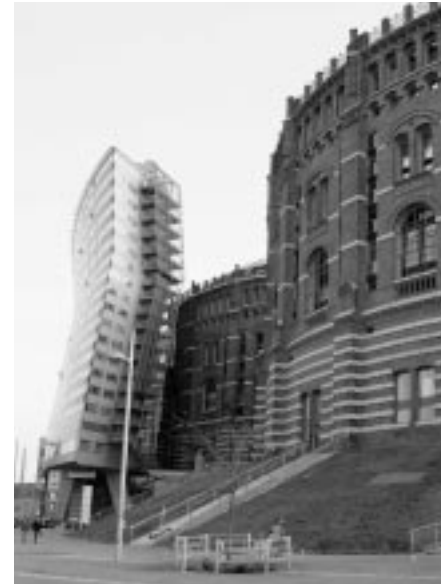
In insgesamt vier Gasometern, die zwischen 1999 und 2001 in Wien-Simmering umgebaut wurden, befinden sich zahlreiche Sozialwohnungen. Foto: ME
