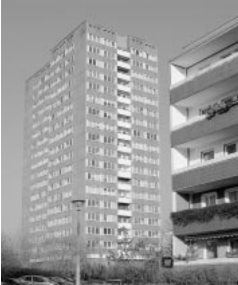
„Angemessene“ Wohnungen gemäß Hartz IV befinden sich in Ostberlin überwiegend in Plattenbauten. Foto: ME
