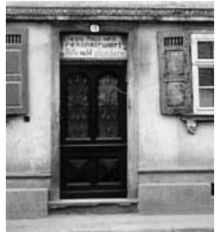
„Dieses Haus wird rekonstruiert! Bitte nicht plündern“ steht über der Haustür. Solche Schilder prägten 1990 das Erfurter Andreasviertel.
