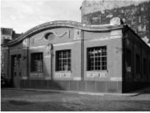
Das Entwässerungssystem Berlins wurde ab 1873 nach Entwürfen von James Hobrecht realisiert. Erst 1909 wurde das abgebildete Pumpwerk Erich-Weinert-Straße in Betrieb genommen. Es steht heute unter Denkmalschutz. Foto: Knut Hildebrandt
