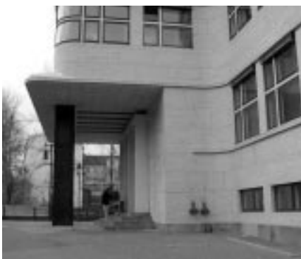
Eingang des Shell-Hauses, Sitz der GASAG am Reichpietschufer in Kreuzberg Foto: Archiv
