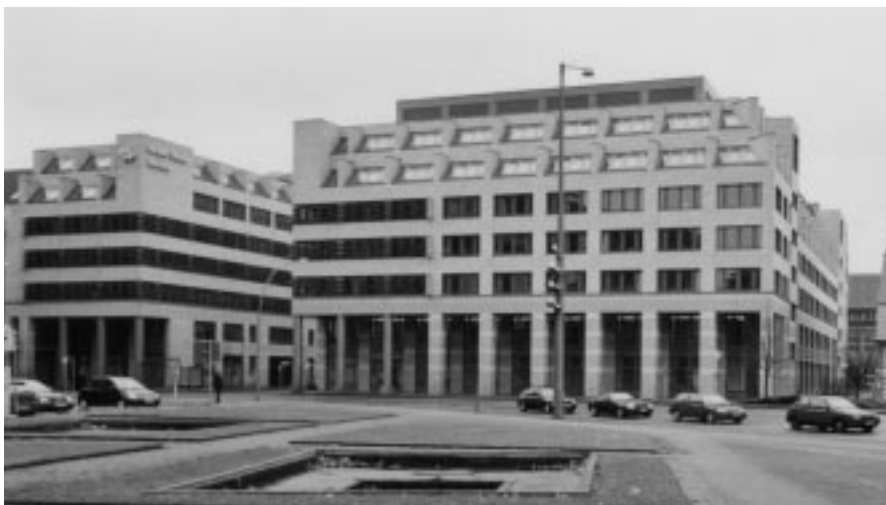
Berliner Wasserbetriebe am Molkenmarkt in Mitte
