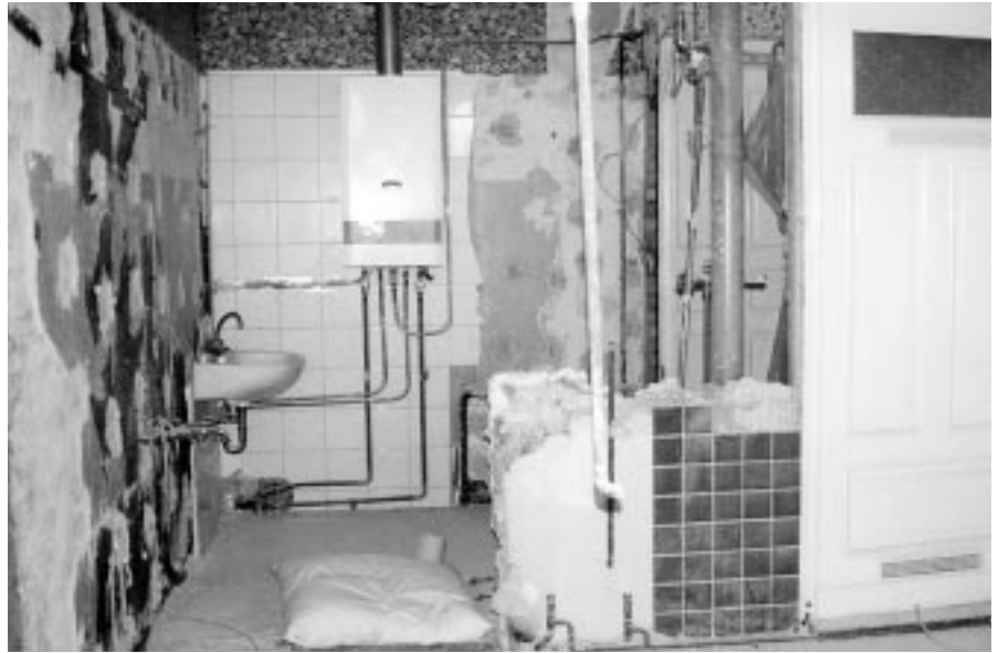
Bad während der Sanierung
