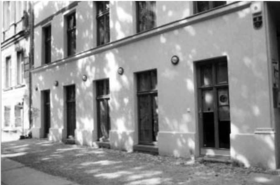
Fehrbelliner Straße 6 nach der Sanierung
