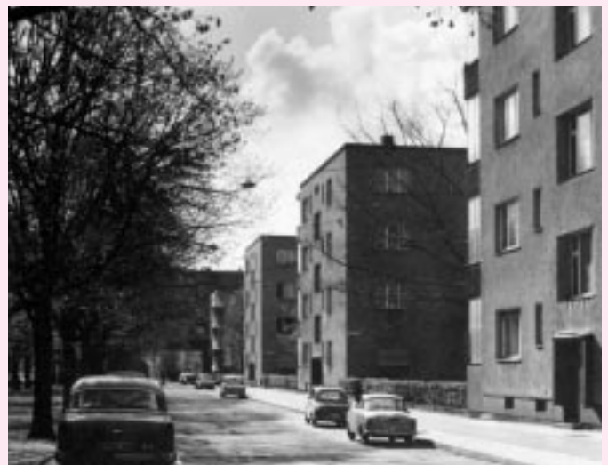
Friedrich-Ebert-Siedlung in Berlin-Reinickendorf, erbaut um 1930
