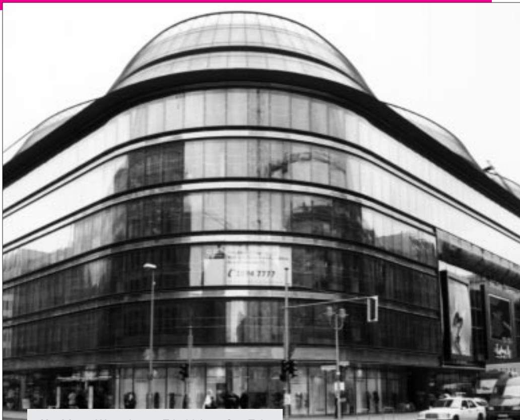
Nachher: Warenhaus, Friedrichstraße, Ecke Französische Straße Foto: 2000
