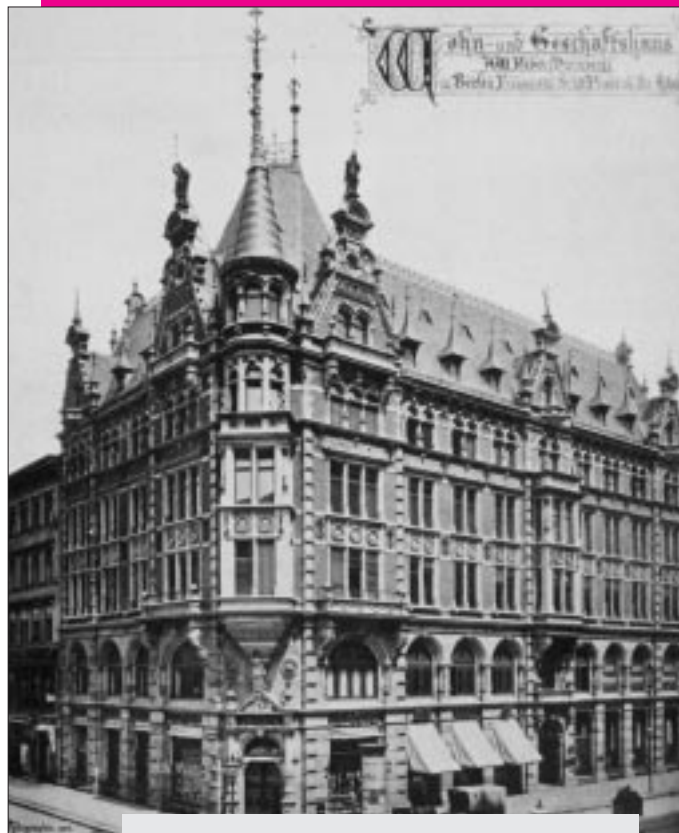
Vorher: Wohn- und Geschäftshaus, Friedrichstraße, Ecke Französische Straße Foto: 1884
