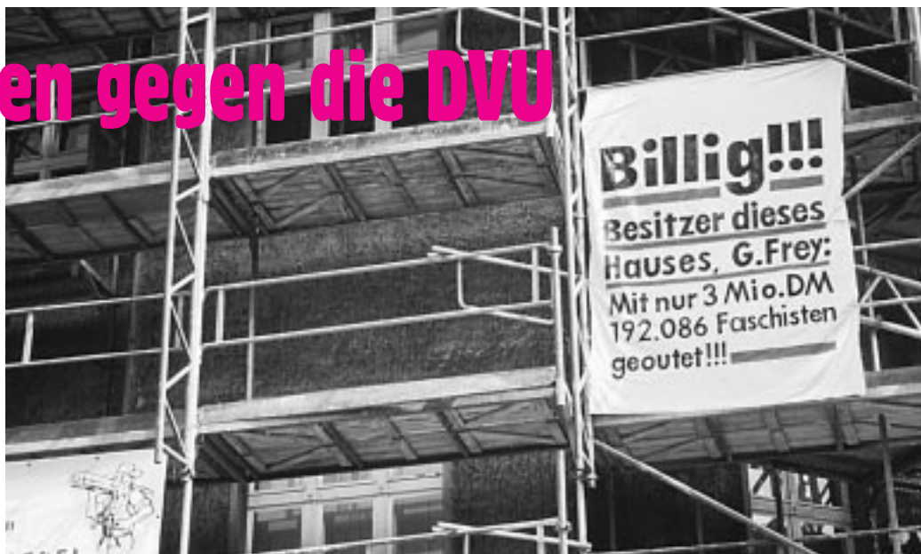
Kurze Zeit zierte dieses Transparent die Fassade eines „Frey“-hauses
