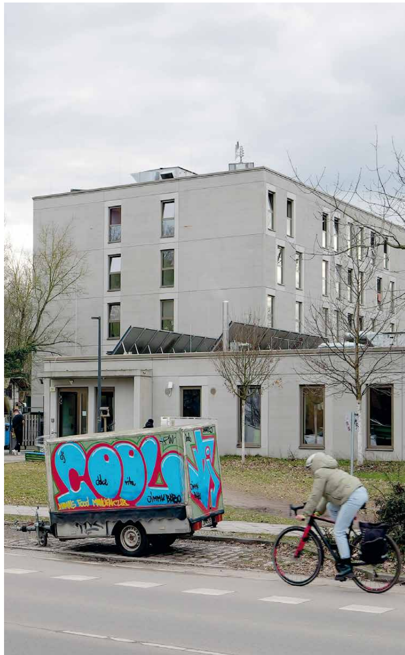
Flüchtlingsunterkünfte als Präzedenzfall für eine umfassende Deregulierung des Bauplanungsrechts. Foto: Matthias Coers
