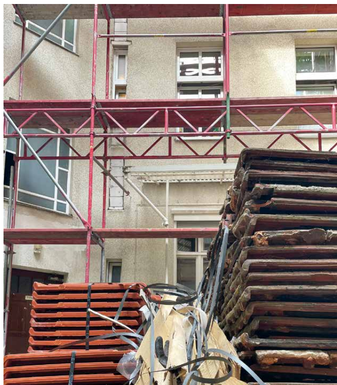
Bei Modernisierungen mit öffentlichen Mitteln müssen diese bei der Berechnung der Mieterhöhung mietsenkend berücksichtigt werden! Foto: Matthias Coers
