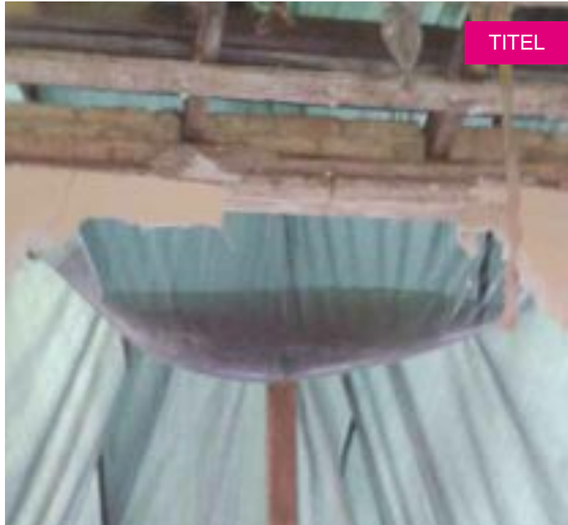
Wassersack von der Abdichtungsplane im obersten Geschoss. Durch die rücksichtslose Modernisierung in der Zossener Straße 4 stand den Mieter/innen teilweise das Wasser in den Wohnungen, da das mit Planen abgedeckte Dach den Regen nicht abhielt. Foto: Privat
