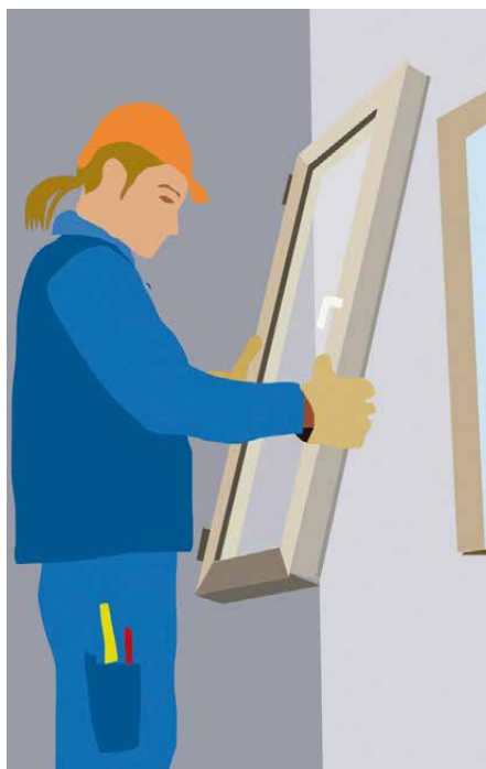
Neue Fenster, die im Zuge von Modernisierungsmaßnahmen eingebaut werden, müssen einen besseren Wärmedurchgangskoeffizienten haben als die alten Fenster.
