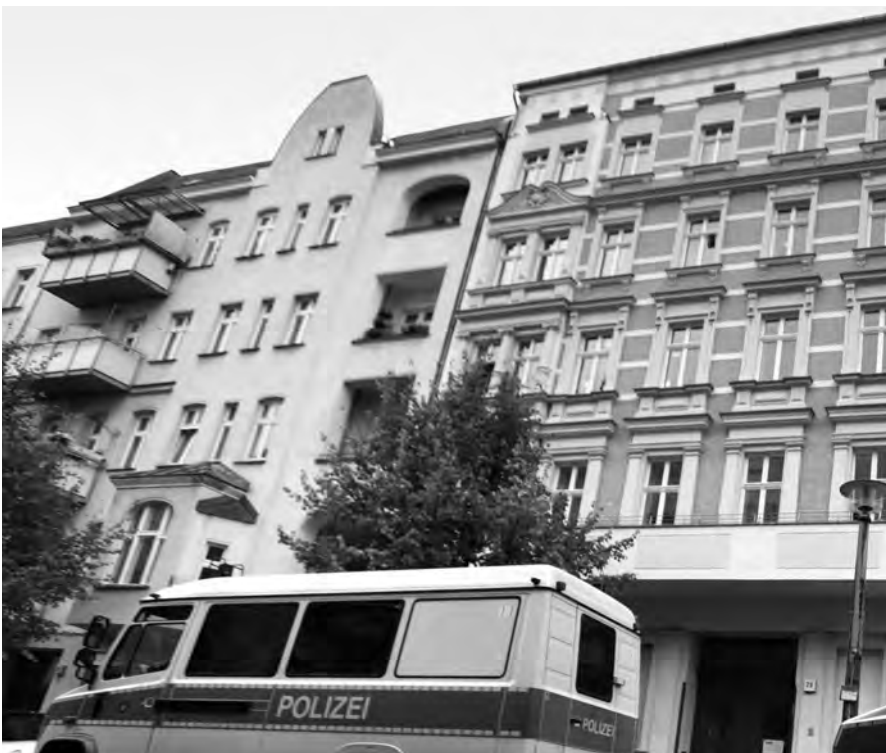
Erster Besichtigungstermin der geräumten Wohnungen in der Scharnweberstraße 29 am 20. Oktober 2010.
