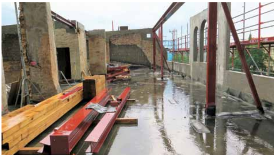
Die unzureichende Dachabdichtung im Haus Havelberger Straße/Ecke Quitzowstraße führte durch wiederholte Wassereinträge zu mehreren unbewohnbaren Wohnungen und zur Gefährdung der Mieter/innen durch unter Wasser gesetzte Stromkabel. Foto: Uwe Klüppel
