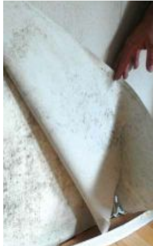
Wenn Schimmelpilz unter der Tapete – also auf dem Putz – entsteht, ist die Ursache wahrscheinlich von außen eindringende Feuchtigkeit durch einen Gebäudemangel. Foto: Götz Autenrieth
