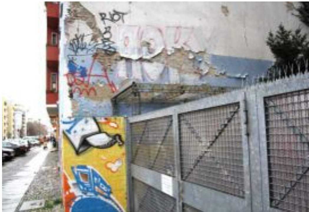
Größere Putzschäden stellen einen schlechten Instandhaltungszustand dar und sind nach dem Berliner Mietspiegel als wohnwertmindernd zu bewerten. Foto: nmp
