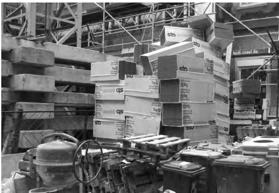
Dämmstoffplatten stapeln sich im Innenhof der Simon-Dach-Straße 31.
