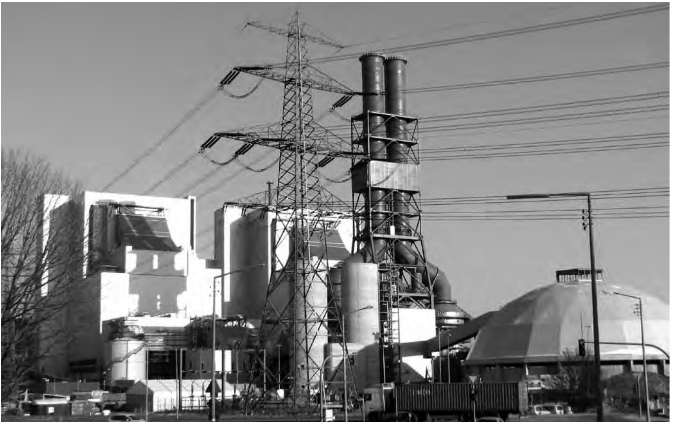
Vorne hui, hinten pfui: Den zur Senkung der CO 2 -Emissionen voran getriebenen Ausbau des Fernwärmenetzes benutzt die Vattenfall Europe AG auch gern mal dazu, Kraftwerksneubauten zu rechtfertigen, wie zum Beispiel beim umstrittenen Kohlekraftwerk in Hamburg-Moorburg. Foto: Florian Muhl/Wikipedia
