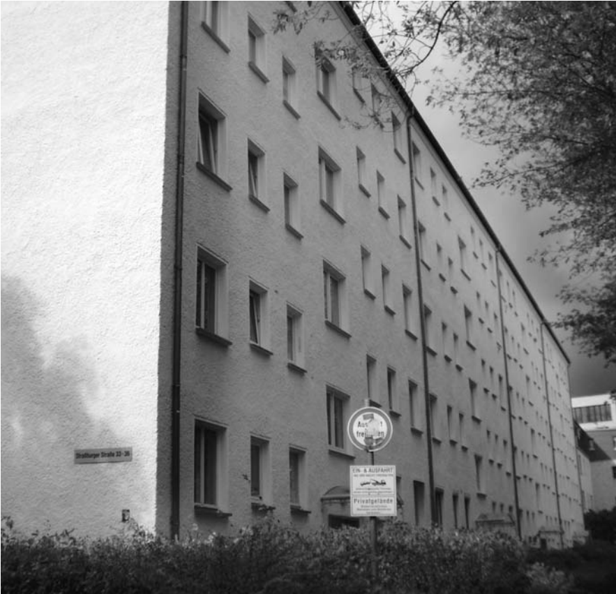
Der Käufer der drei Wohnblöcke in der Straßburger Straße, die Firma Econcept Immobilien und Projektentwicklung GmbH & Co KG, plant die Aufstockung der Gebäude um zwei Vollgeschosse und den Abriss von 20 Wohnungen, um auf der so gewonnenen Fläche eine Blockrandschließung vorzunehmen.
